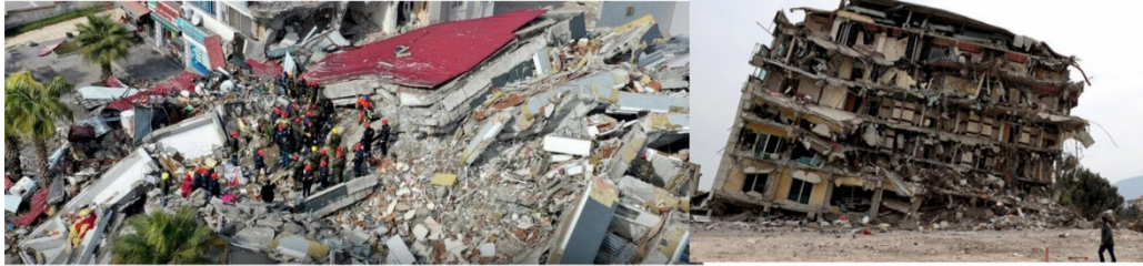
Depremde binaların yıkılması ve yapı hasarı
