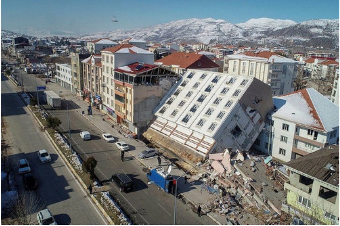
Alüvyon en zayıf zeminde yapılmış binanın depremde sınılaşma ile yan yatması.
