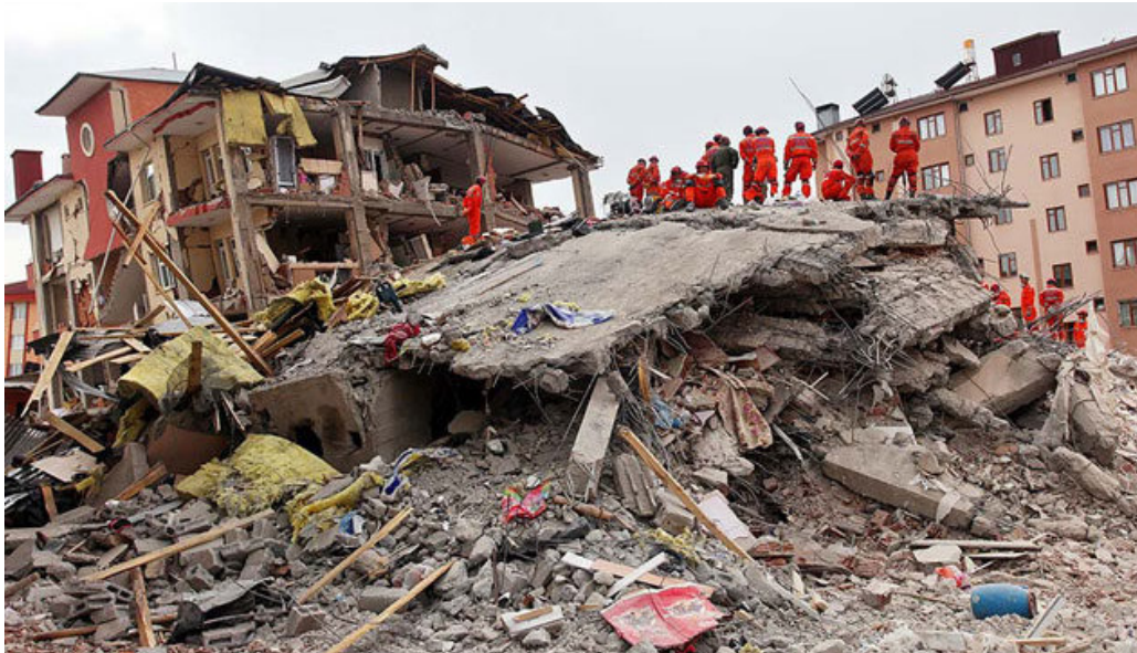
Depremde binaların yıkılması ve hasar görmesi.
