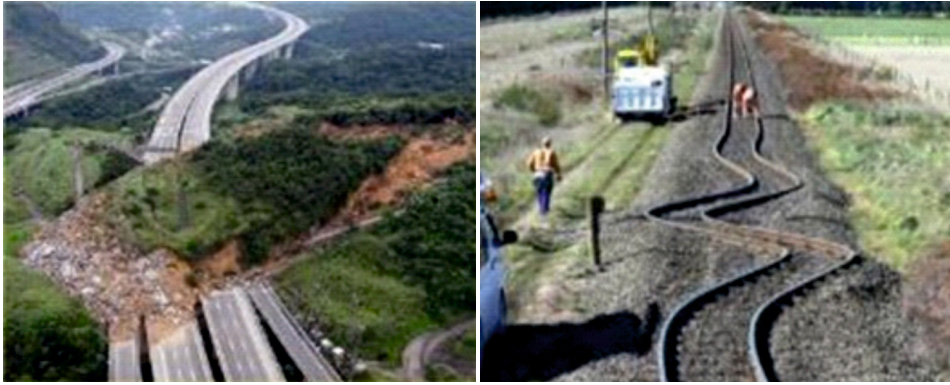
Deprem sırasında oluşan heyelan ve demiryolunun bükülmesi
