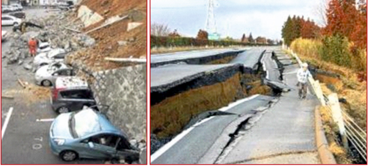
Deprem sırasında duvarların çökmesi ve yerde gelişen çökme.
