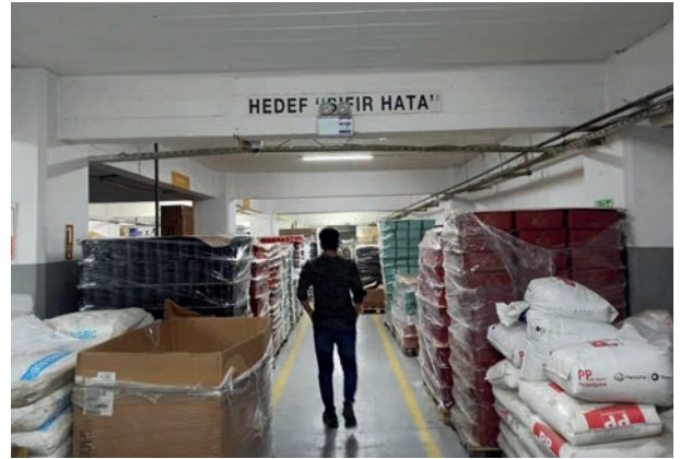
Görsel: Acil yönlendirme levhası istiflenilen malzemelerin arkasında kalmış. Fotoğraf Murat Uysal.
