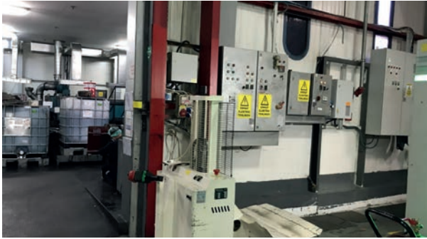
Görsel: İşçilerin kolaylıkla göremeyeceği kadar yükseğe ya da önüne malzeme/teçhizat konulmuş sağlık güvenlik işaretleri. Fotoğraf Emirali Karadoğan'ın kişisel arşivinden alınmıştır.
